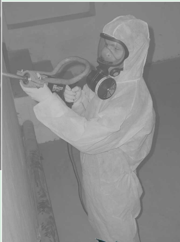
jednotka CA Asbest, přímo připojená k celobličejevé masce
