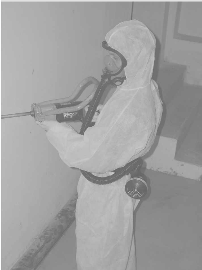
jednotka CA Asbest, varianta propojení s maskou pomocí hadice
